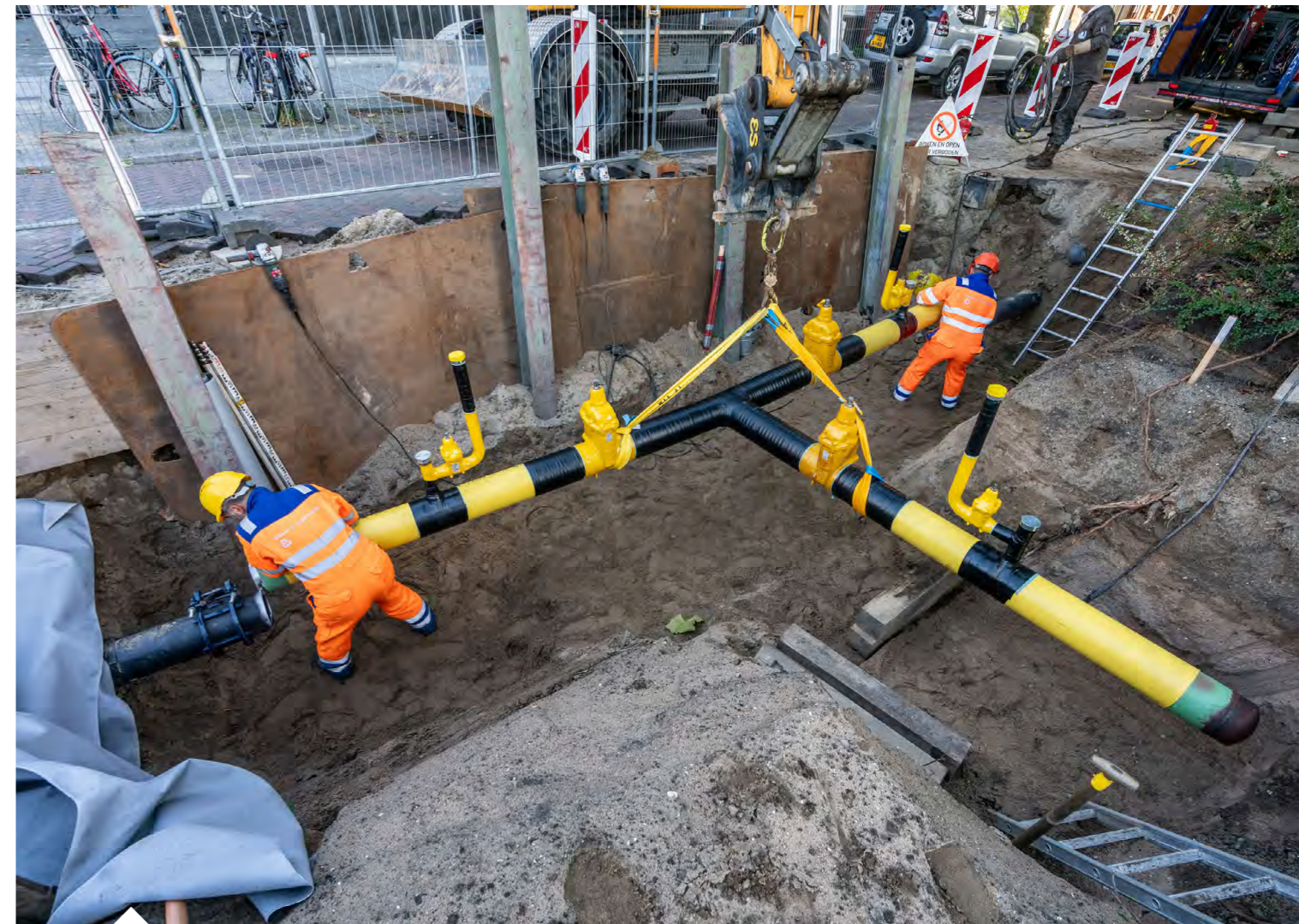
Centrum Rotterdam aanpassing hoofdgasleiding door Visser & Smit Hanab Distributie.
