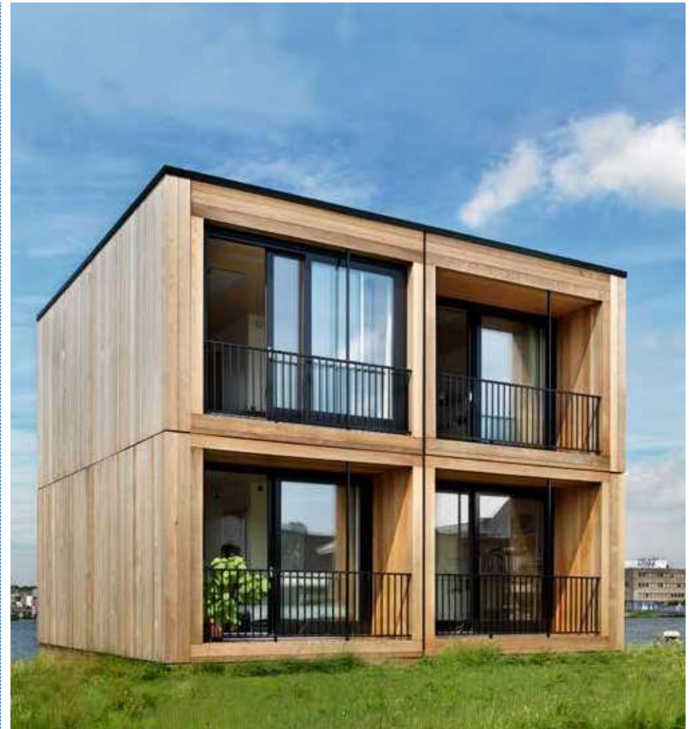
De houten woonmodule van Finch Buildings gebruikt natuurlijke materialen, waarvan een aantal cradle-to-cradle gecertificeerd is. Het slimme ontwerp en prefabricatie zorgen voor minder afval.
