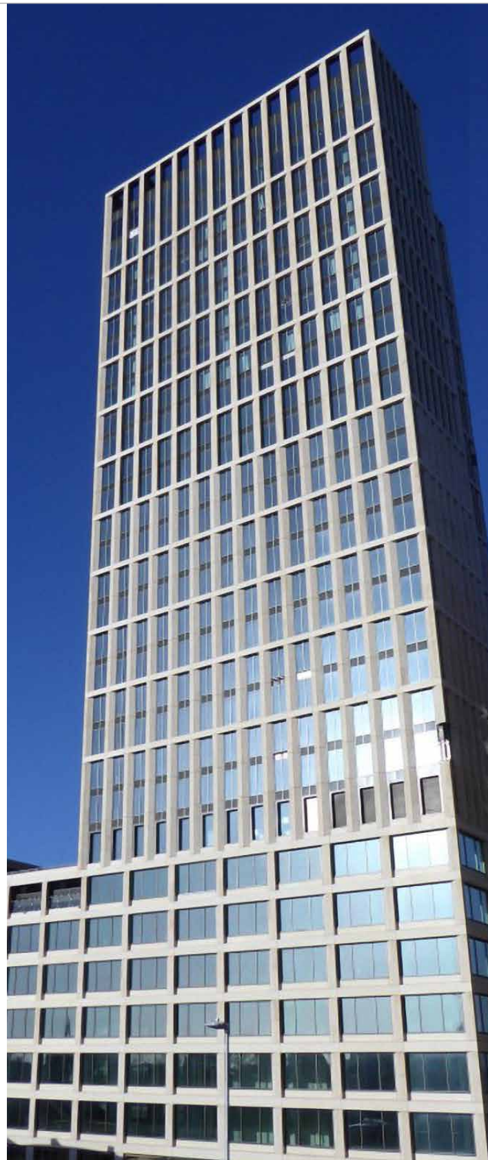
Bouwcombinatie FIRST (bestaande uit VolkerWessels-ondernemingen Boele & van Eesteren en Wessels Zeist) heeft kantoorgebouw FIRST Rotterdam gerealiseerd. Recht tegenover het Rotterdam Centraal station, markeert FIRST Rotterdam de entree naar de binnenstad.
