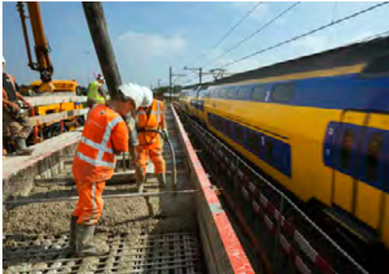
Van Hattum en Blankevoort pours concrete for OV SAAL.
