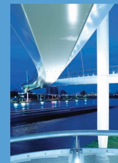
Volker Staal en Funderingen ontving in 2006 de Nationale Staalprijs voor de bouw van de Nesciobrug in Amsterdam.
