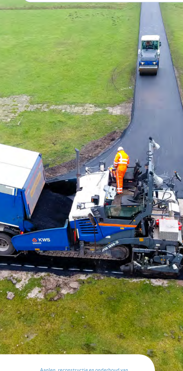
Aanleg, reconstructie en onderhoud van asfaltwegen vormt de kern van ons infrastructurele werk.
