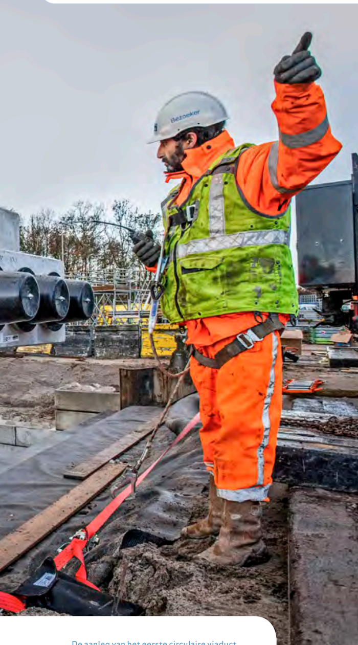
De aanleg van het eerste circulaire viaduct.
