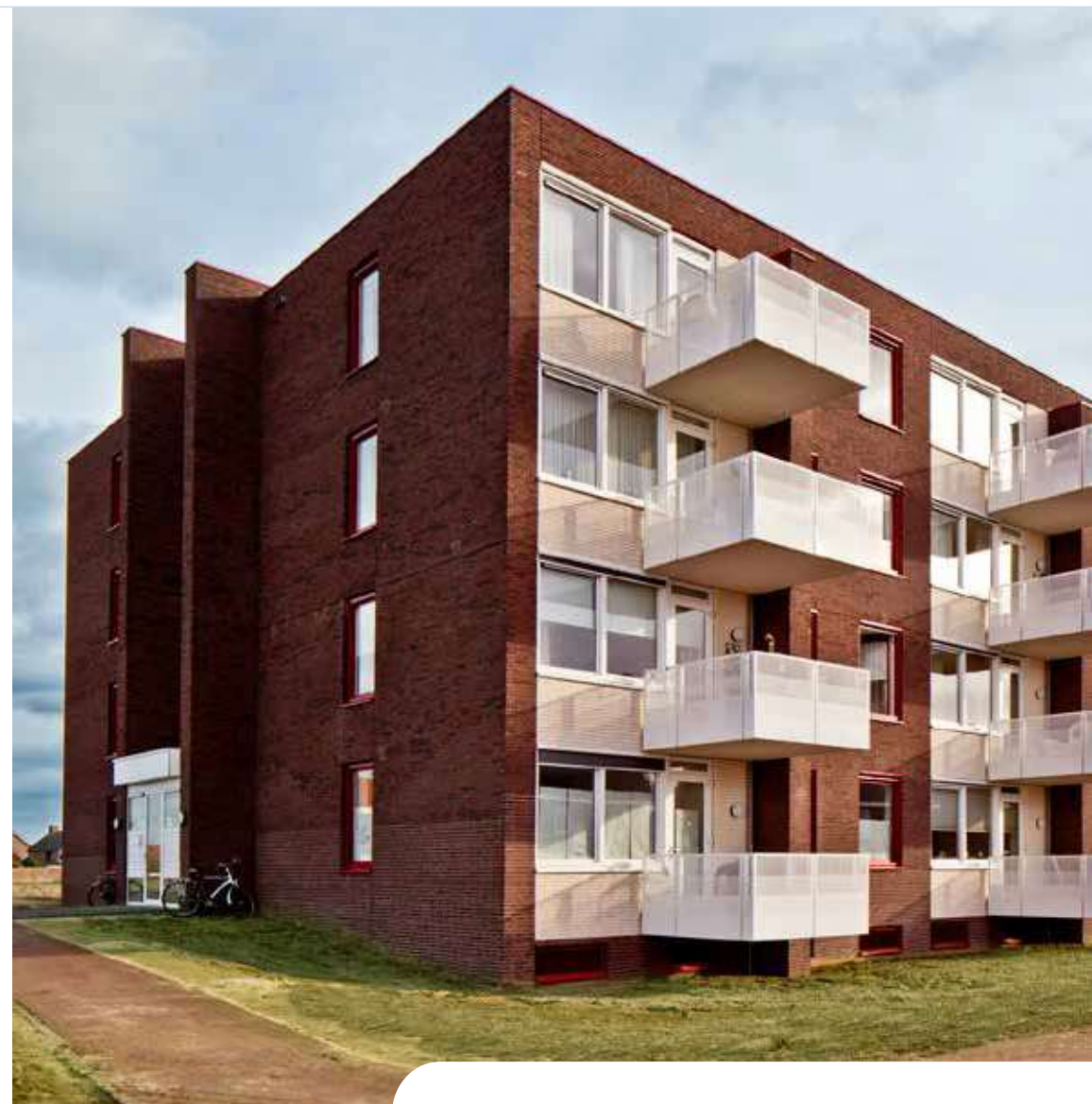
Project Oppe Brik: een nieuwe woonwijk in Limburg bestaande uit 28 nul-op-de-meter-appartementen. De woning is gasloos en heeft een netto energieverbruik van 0.
