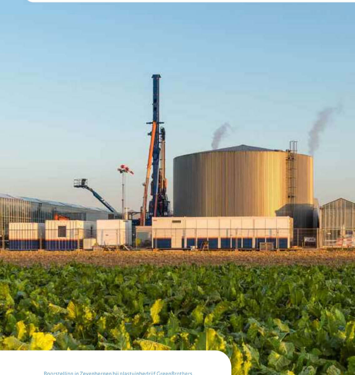
Boorstelling in Zevenbergen bij glastuinbedrijf GreenBrothers. De auberginekwekerij wordt van duurzame energie voorzien, in de vorm van lage temperatuur aardwarmte. Dit is een primeur!
