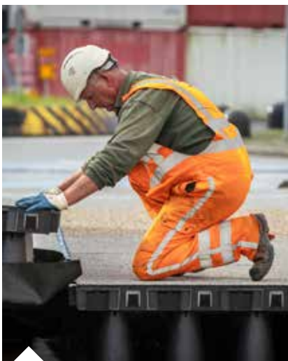
Aanleg van PlasticRoad op Schiphol
