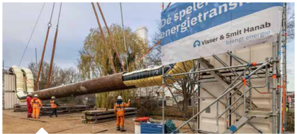
Zinkerpakket in de watergang, parallel aan de Brilledreef in Utrecht.
