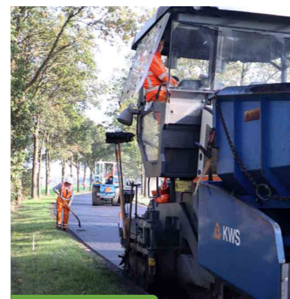
Op de N331 (Vollenhoverweg) bij Marknesse voerde KWS een pilot uit met een duurzaam asfaltmengsel, dat voor 50% bestaat uit gerecycled SMA (steen- of splitmastiekasfalt).
