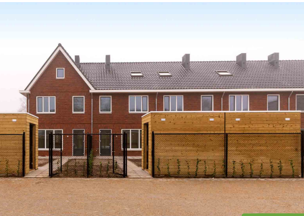
In nieuwbouwproject Hollandse Linde in Ede is dit jaar de 2000 e MorgenWonen woning geassembleerd.
