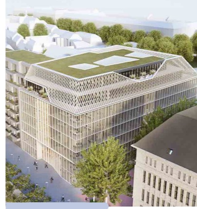
In 2020 zijn we gestart met de bouw van het nieuwe hoofdkantoor voor Alltours Flugreisen in Düsseldorf.
